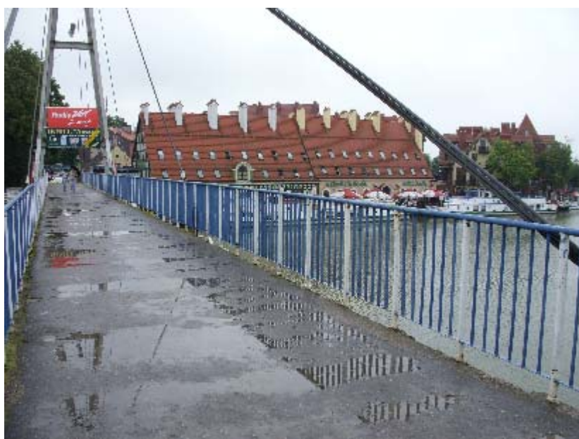
Kładka w stanie obecnym.
